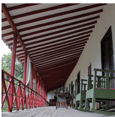
02. Pasillos de la Casa Gutiérrez.
